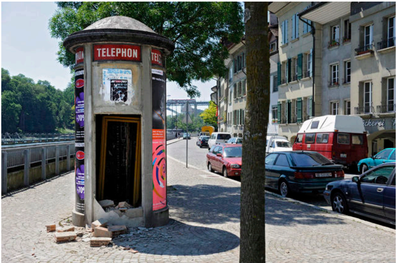
Die Litfasssäule wurde letzte Woche zum ersten Mal demoliert. (Adrian Moser)
